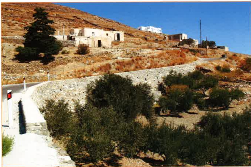
Τειχίο στο Καλάμι
