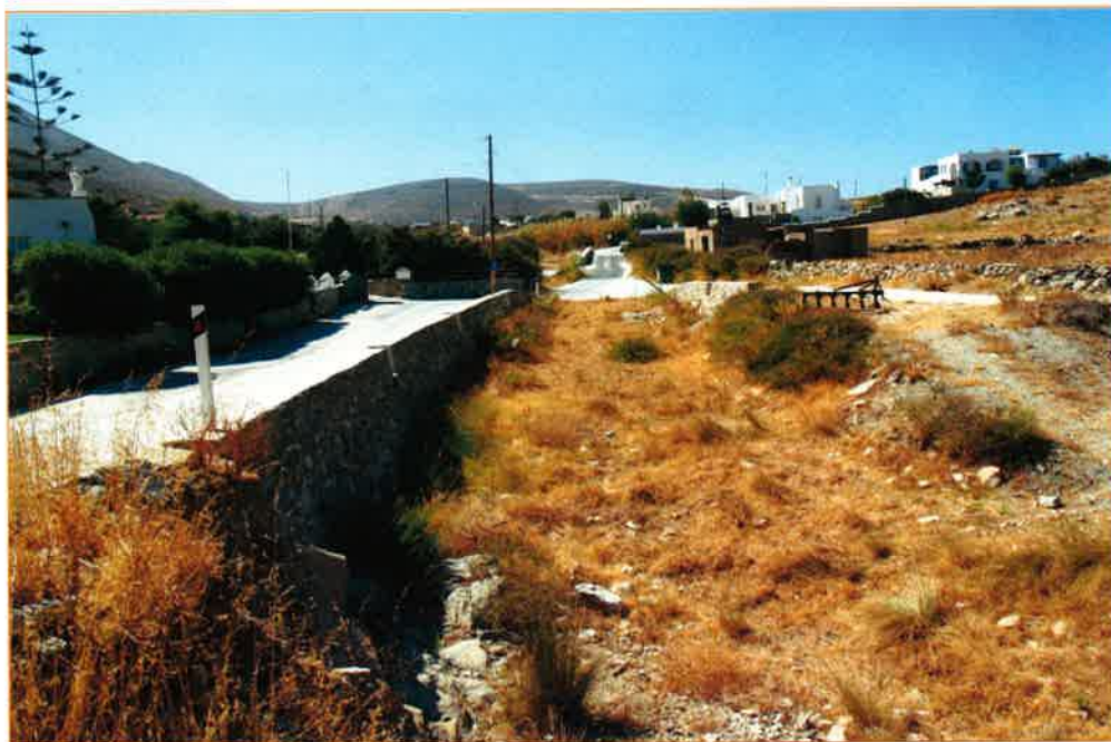
Τειχίο και τσιμεντόστρωση στα Κακάπετρα
