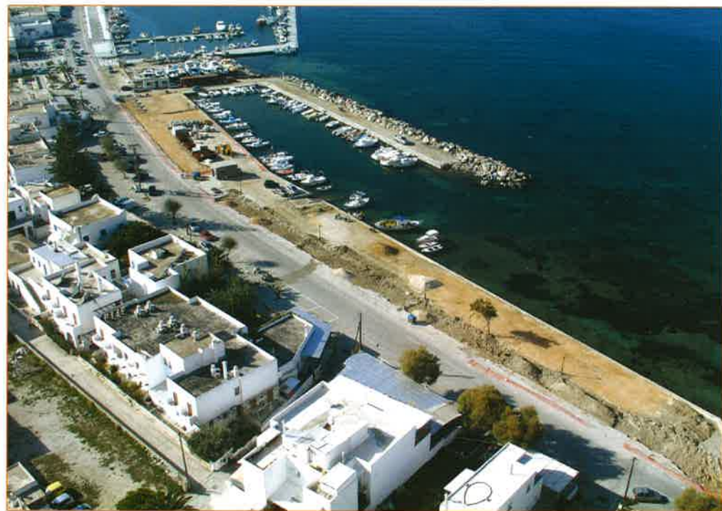
Οκτώβριος 2005, έναρξη εργασιών
