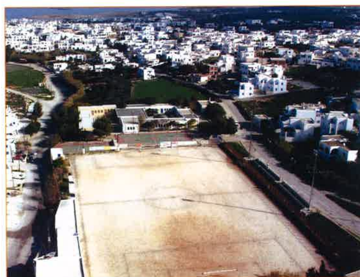
Ο χώρος που ξεκινούν οι εργασίες κατασκευής
